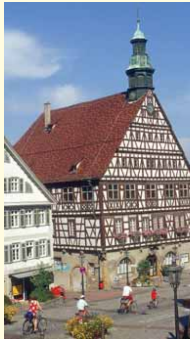
Fachwerkhaus in Backnang
