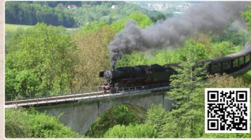
Dem kleinsten und zuerst vollendeten Viadukt der Wieslaufbahn begegnet man auf Höhe des Ortsteils Klaffenbach. Es überspannt den Igelbach mit einem Dreiecksbogen von 27 Meter Stützweite. Genau die gleiche Wölbung hat der mittlere Bogen des Laufmühlenviadukts. Das ist kein Zufall, sondern schlaue Ingenieurskunst und preisgünstige Planung, denn so konnte dasselbe Lehrgerüst – die Holzunterkonstruktion für den Bogen – zweimal verwendet werden. Das Viadukt quert den Igelbach in 15 Metern Höhe.
